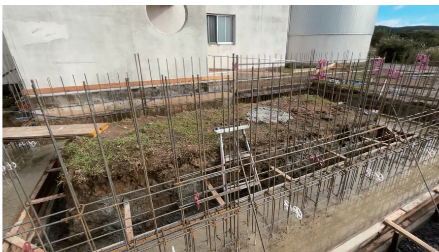
図 1: 仮眠棟の基礎工事
