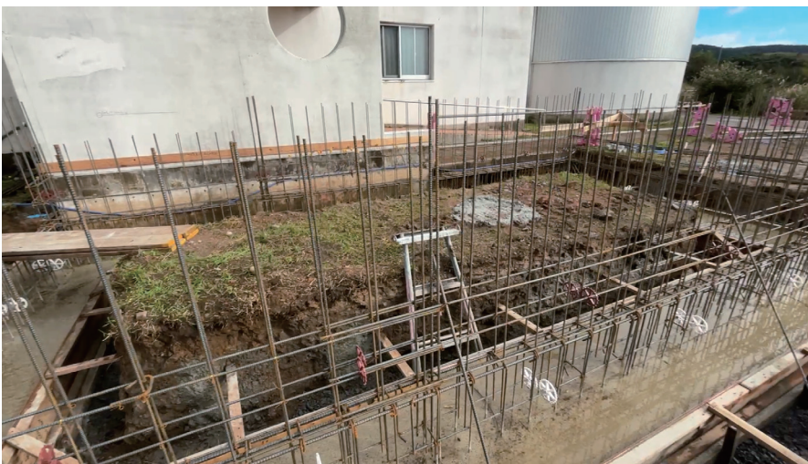
図1: 仮眠棟の基礎工事
