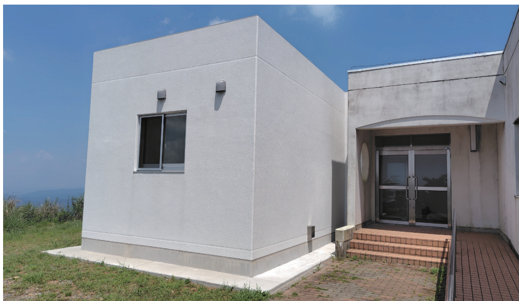
図2：増築された仮眠棟の外観
