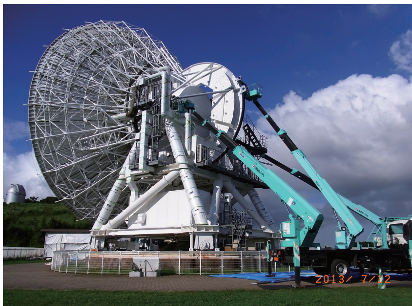
写真：2013 年夏に行われた VERA 入来局 20 m 鏡の再塗装の様子。(左) 高所作業車で鏡面の裏側やセクターギア周辺にアクセス。(右) 副鏡周辺の塗装。鏡面保護のため、下半分には青い養生シートを設置。
